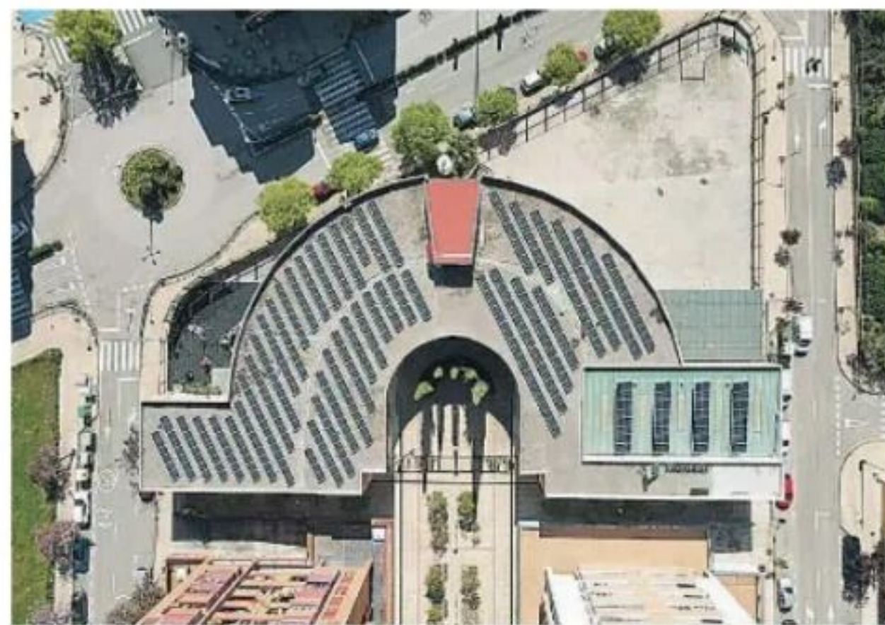
La empresa suma 98.000 centros de transformación y mil subestaciones
